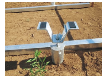
② 施工誤差吸収の設置
