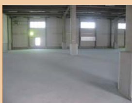
コンクリート打設1ヶ月後
