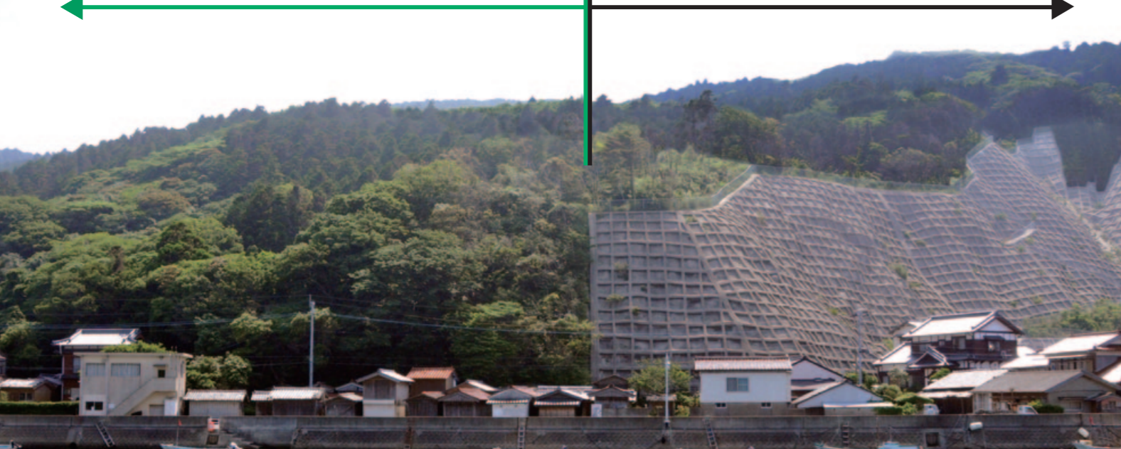
1 ノンフレーム工法で施工した斜面は、自然も守られています。
