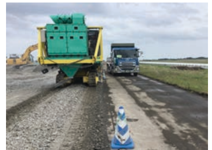
▲コンクリート舗装版撤去工事(220SM:新田原基地)
